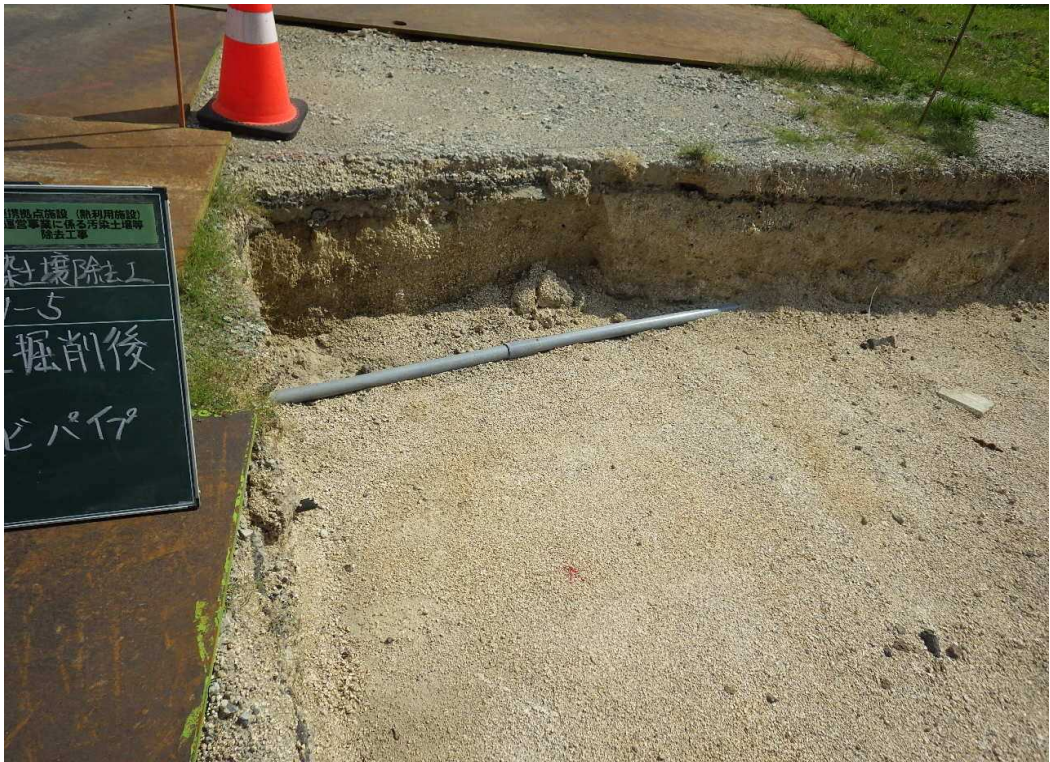
C1-5区画 給水管・電気ケーブル
