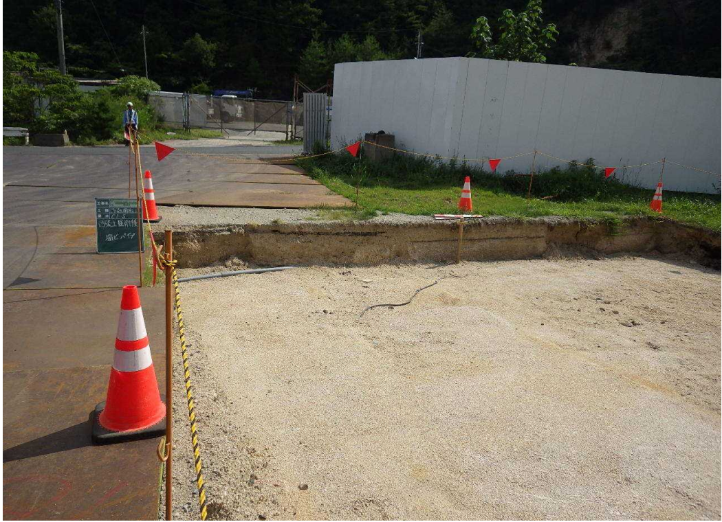
C1-5区画 給水管・電気ケーブル
