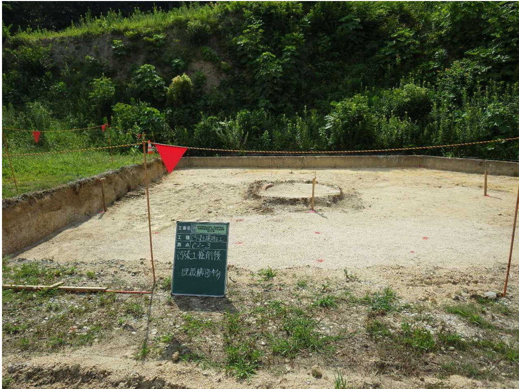
C 2 - 3 区画 煙突基礎
