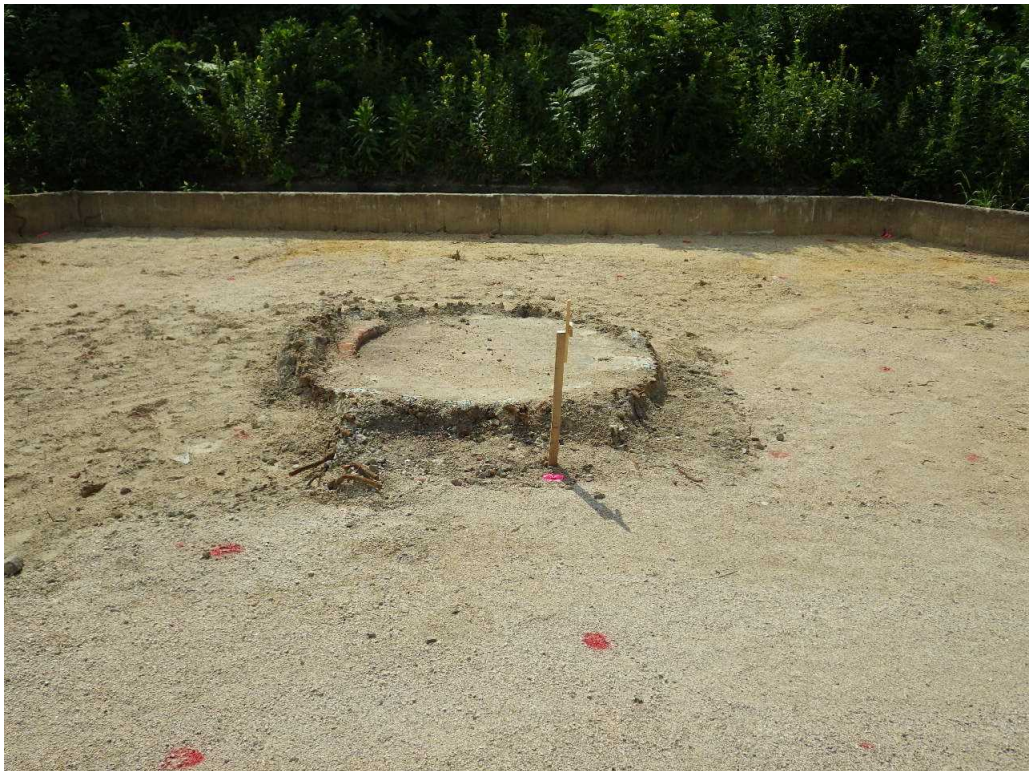
C 2 - 3 区画 煙突基礎
